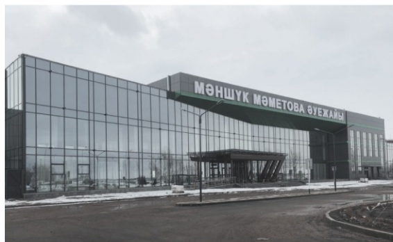
РЕКОНСТРУКЦИЯ ЗДАНИЯ АЭРОПОРТА ГОРОДА УРАЛЬСК
